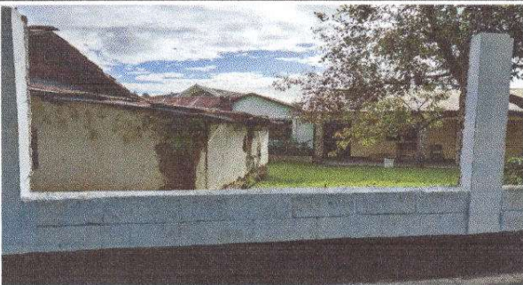
Foto: 5 Cambio de malla que esta rota
