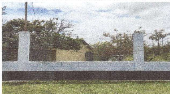
Foto: 4 Cambio de malla en mal estado
